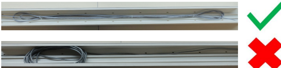
Abb. 10: Kabel richtig verlegen.
