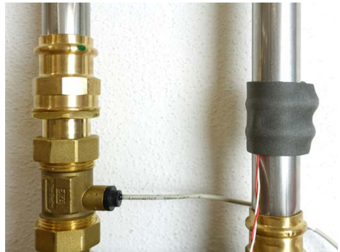
Abb. 32: Ummantelung mit Komtriband
