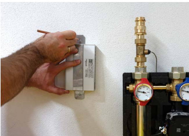
Abb. 13: Geringer Abstand zwischen Stan 2.0 und dem Hydraulikmodul Abb. 14: Zwei EFG-Link-Kabel
