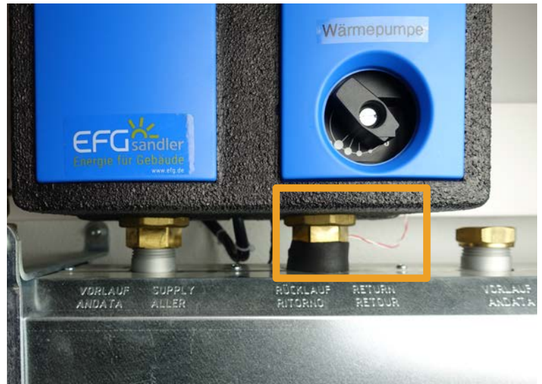
Abb. 26: Hinweis zur optimalen Platzierung des Systemtemperatur-Sensors
