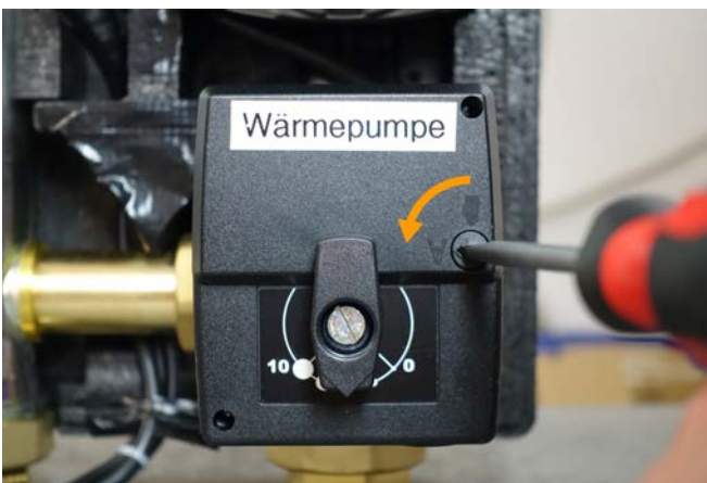
Abb. 50: Mischventil auf Automatik zurückstellen
