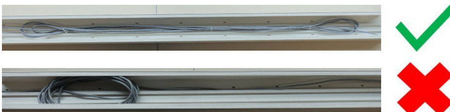
Abb. 15: Kabel richtig verlegen.
